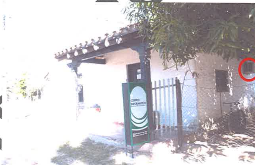
Empresa privada Fuente: verificación in situ de fecha 13/07/20
