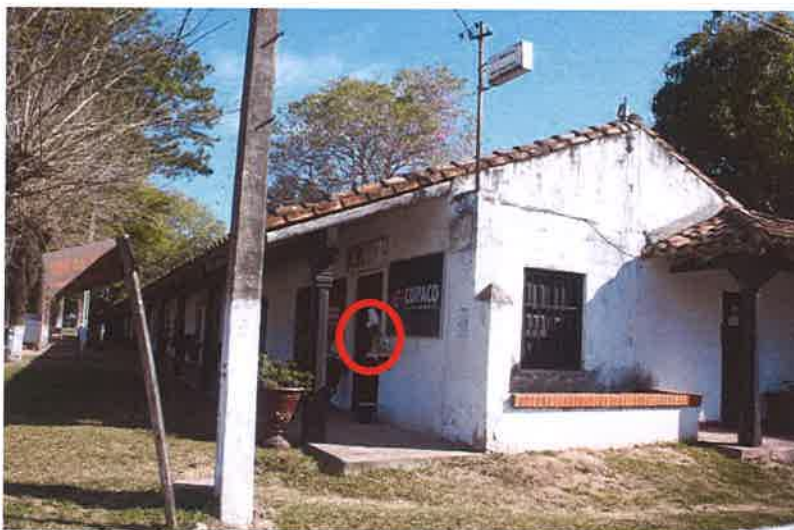
Dependencia del Registro Civil y Copaco Fuente: verificación in situ de fecha 13/07/20
