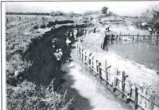
FOTO 06: Dique construido para permitir la retirada de los pecios y que no fue eficiente.
