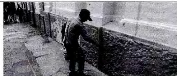
Foto 01: Pintura parcial de fachada.
