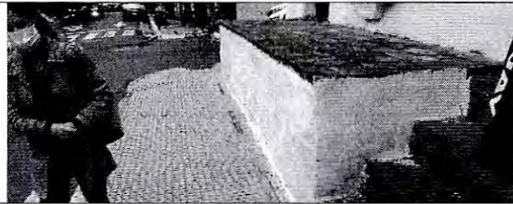
Foto 13: Inspección de relevamiento de necesidades. Instalación de nueva iluminación.
