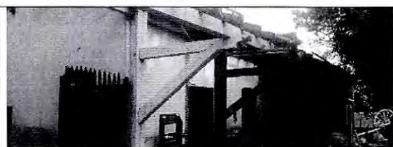
Foto 24: Biblioteca Pública de Iturbe / Guairá. En obras 70%.
