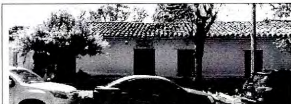
Foto 29: Biblioteca Pública Caazapá / Caazapá. Proyecto concluido. Licitación.
