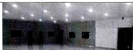
Foto 22: Biblioteca Pública Capitán Bado / Amambay. Concluida.
